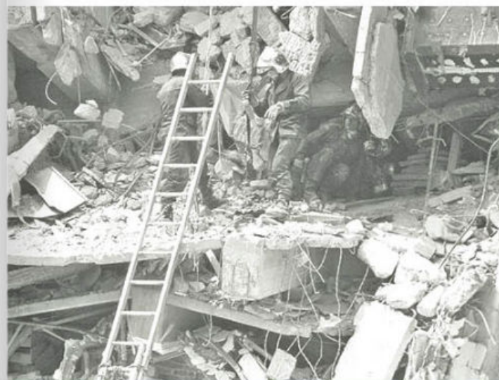
Figura 5.28. Rescatistas en uno de los edificios colapsados por el sismo del 19 de septiembre de 1985.
